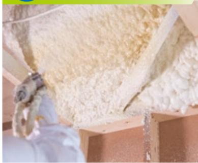
熱橋金物にも吹き付け(断熱補強)
